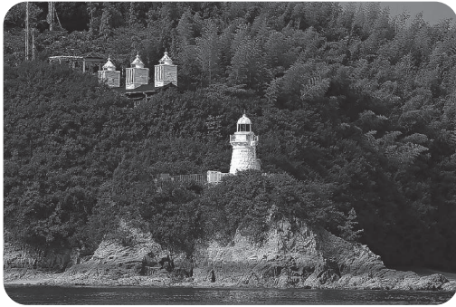
写真4 大浜埼灯台、奥の塔屋3基の建物は旧大浜埼潮流信号所（灯台記念館）です。
