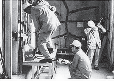
曲げ型を徐冷炉へセット
