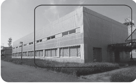
上：横浜 試験センター 工場施設 下：立川 試験センター レンズ製作棟
