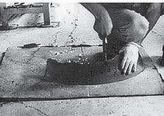
荒摺り部分の除去
