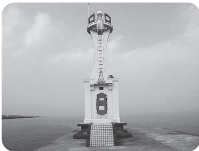
千代崎港南防波堤灯台
