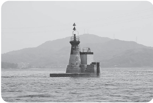
写真7 長太夫礁灯標、かつては百貴島灯台の灯台守が小舟で燃料補給と保守をしていました。
