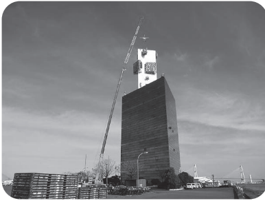
空中線回転機構部の交換工事
