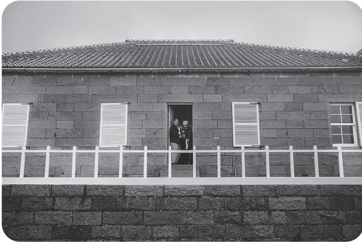
写真6 旧官舎の玄関で灯台を確認
