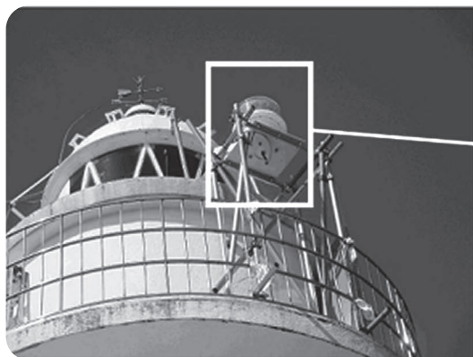
【写真5】仮の灯器による応急復旧状況
