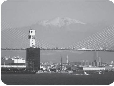
名古屋港海上交通センター全景
