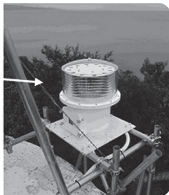
【写真5】仮の灯器による応急復旧状況
