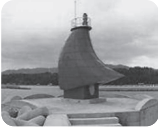
淡輪港西防波堤灯台
