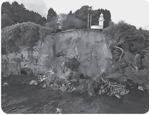
写真2 能登観音埼灯台敷地が震災により崩落
