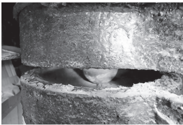
図13 潮岬灯台の耐震装置の金属ボール (令和2年撮影)
