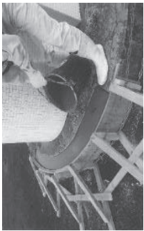
亀裂部の補修を行い、海水や雨水の浸入を遮断する。
